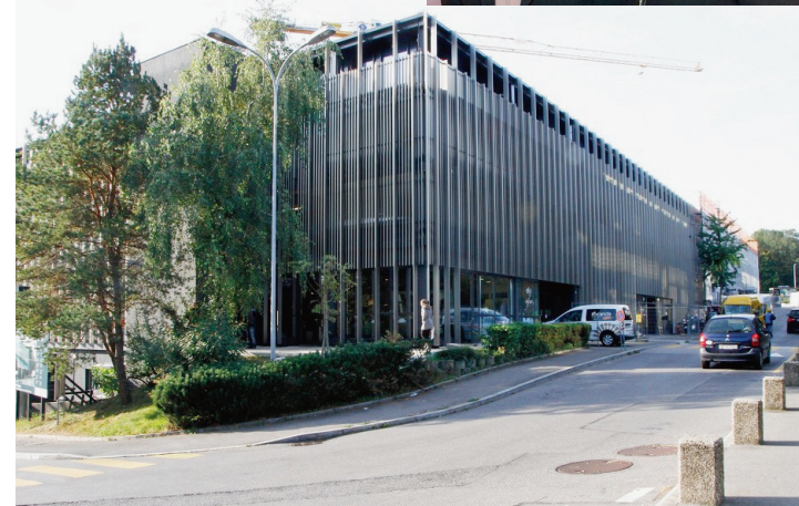
Le bâtiment est aujourd'hui enveloppé de barres d'aluminium. Photo du haut: Mario Di Pietrantonio, Fonds Altum Management, et Noémie Goldman, Architectures & Retail Rites. C. SANDOZ ET ARCH. C. REUILLE
